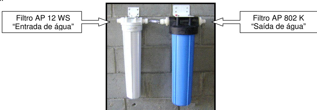
Figura 9 – Montagem final dos filtros
